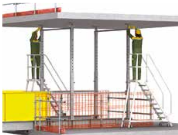
5 Mettre en position les 4 étais, puis décrocher les 4 chaînes de levage de la grue et enlever les moises arrières.
