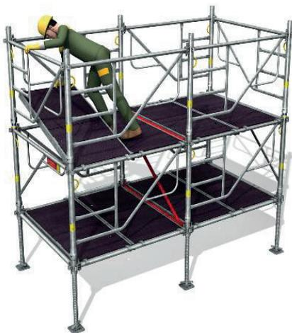
**6** Accès au niveau supérieur puis pose du 4<sup>e</sup> plancher à trappe.
