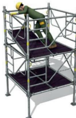
**6** Accès au niveau supérieur puis pose du 2<sup>e</sup> plancher à trappe.
