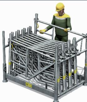
**Les cadres sont colisés verticalement et à l'endroit** pour éviter de se pencher pour les redresser ou de les retourner.
