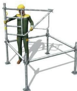
**2** Depuis l'intérieur de la tour, pose du 1<sup>er</sup> cadre dans l'axe de la diagonale puis rotation pour le verrouiller.
