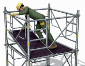
Descendre le plancher **en prenant appui sur le cadre.**
