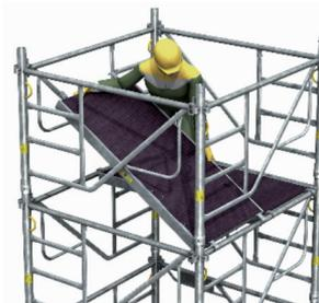
Pour faciliter la pose, maintenir l'extrémité avec la main droite et l'avant bras. **Poser en premier les 2 crochets sous l'échelle.**
