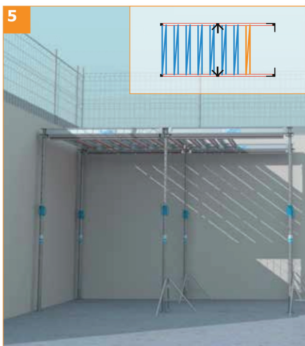
5 Reprendre la mise en place des cadres secondaires.
